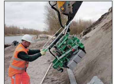
Für steile Böschungen ist das Modell P02-3 prädestiniert
